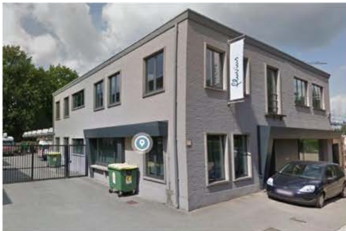
De gemeente Vosselaar koopt het voormalig administratief kantoor van Fluvius in de Nijverheidsstraat aan. Dat kantoor ging in november 2019 dicht. — © RR
